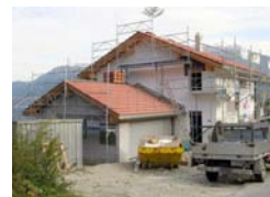
Chantier nouvelle maison d'habitation dans le canton des Grisons
